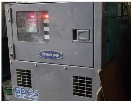
◇発電機の設置には、事前に、電気工事士による配電基盤などの工事が必要です。
